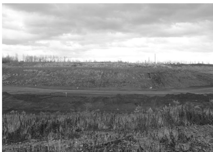
Skládka kovonosných kalů r. 2012
